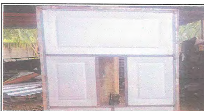
Foto 6: REMOZAMIENTO DE PUERTA
