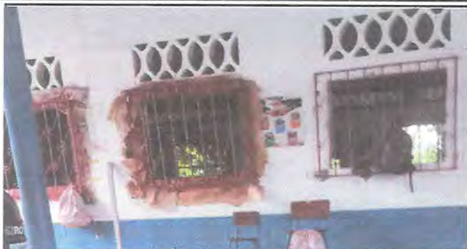
Foto 1: REMOZAMIENTO DE PINTURA BALCONES
