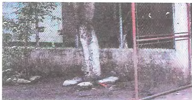
Foto 3: REMOZAMIENTO DE PINTURA DE PORTALES
