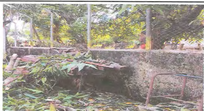
Foto 5: REMOZAMIENTO DE MURO PERIMETRAL
