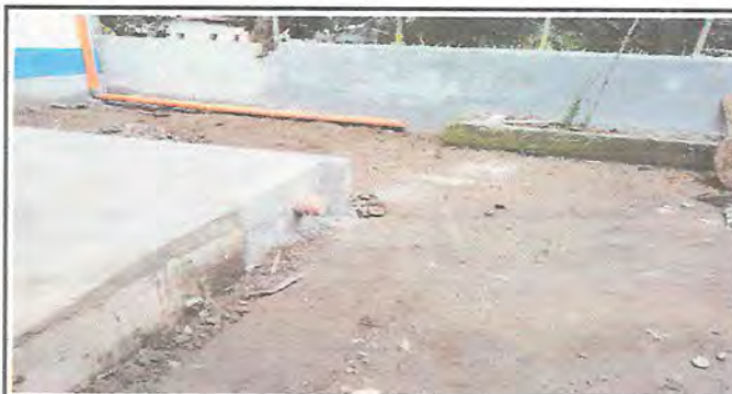
Foto 6: REMOZAMIENTO DE LOS BAÑOS
