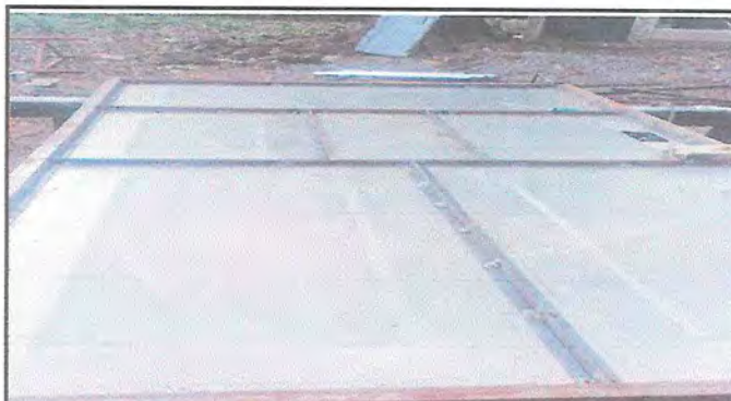
Foto 4: REMOZAMIENTO DE PUERTA
