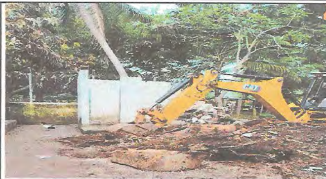
Foto 2: REMOZAMIENTO DE LOS BAÑOS
