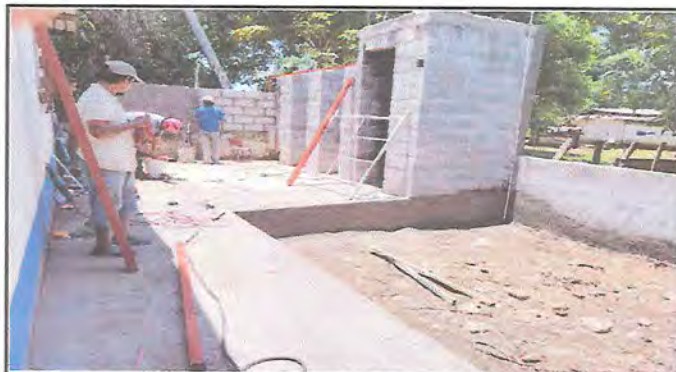
Foto 4: REMOZAMIENTO DE LOS BAÑOS
