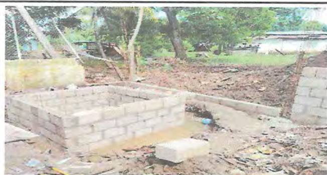
Foto 5: REMOZAMIENTO DE LOS BAÑOS
