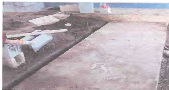
Foto 4: REMOZAMIENTO DE MURO PERIMETRAL
