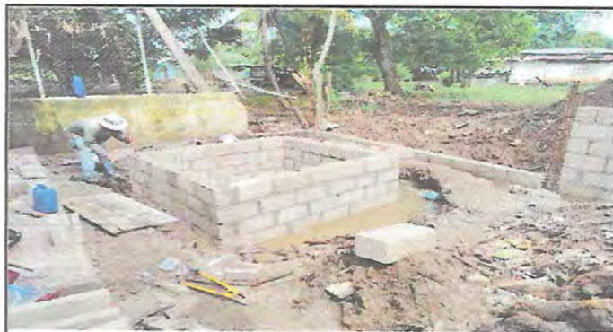
Foto 3: REMOZAMIENTO DE LOS BAÑOS
