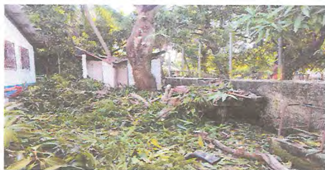
Foto 1: REMOZAMIENTO DE LOS BAÑOS
