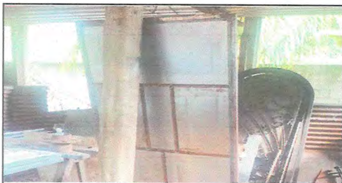
Foto 5: REMOZAMIENTO DE PUERTA
