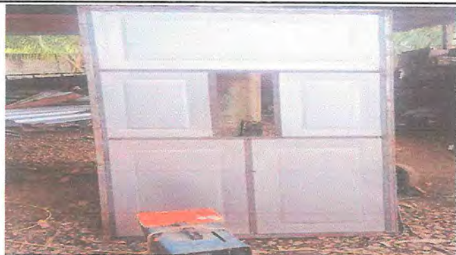
Foto 1: REMOZAMIENTO DE PUERTA
