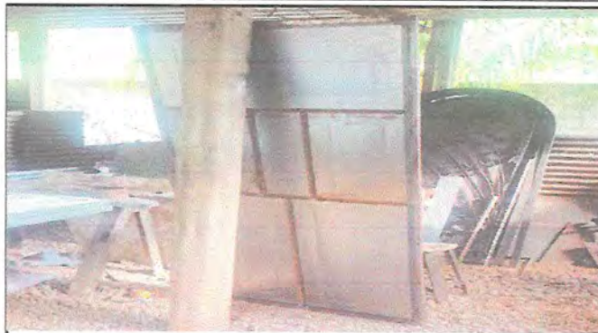
Foto 2: REMOZAMIENTO DE PUERTA
